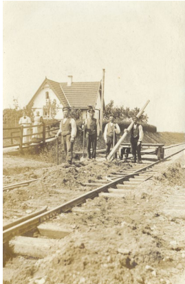
Ill. 13 Anlægsarbejde ved Kelstrup Station 1899
