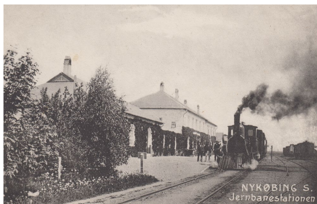
Ill. 19 Nykøbing Sjælland station omkring 1905.
