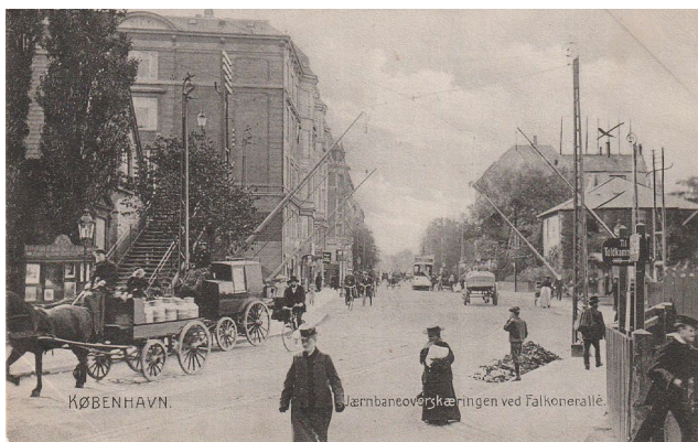
Ill. 15 - Kortet her fra 1906 viser Fredriksund og Vestbanen jernbaneoverskæring ved Falkonerallé. Indtil 1911 skulle alle tog til og fra Hovedbanegården passere frederiksberg. Hvilket gav et afbræk for gade-trafikken på bl.a. H.C. Ørstedvej, Bülowvej mv. Men med åbningen af den nuværende Hovedbanegård, blev jernbaneoverskæringerne nedlagt. Jernbanebygningen til venstre på kortet blev nedrevet og senere erstattet med Frederiksberg S-toget Station, der igen måtte vige pladsen for Frederiksberg Centret.
