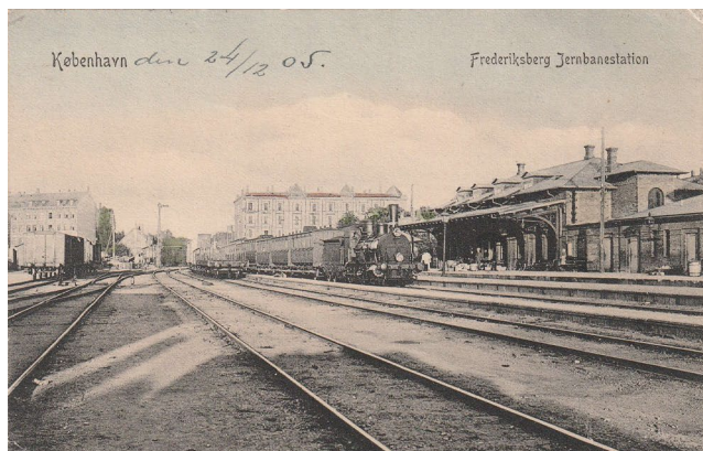
Ill. 14 - Ved åbningen af Københavns tredje og nuværende Hovedbanegård i 1911, blev jernbanelinjerne omlagt. Således at man ikke mere fra Frederiksberg Station kunne entre toget direkte til Gedser eller Korsør. Stations bygningen tabte sin betydning og var nær ved at blive revet ned i forbindelse med bygningen af Frederiksberg Centret. Men bygningen blev heldigvis reddet, da bl.a. Sven Auken og Jørgen Jørgensen, mangeårige bibliotekar i Frederiksberg Frimærke Forening aktiv gik ind i høringer for bevarelsen af den historiske bygning. I dag ligger bygningen som en aktiv og smuk tidslomme mellem Frederiksberg Centret og den nye Metro Station.
