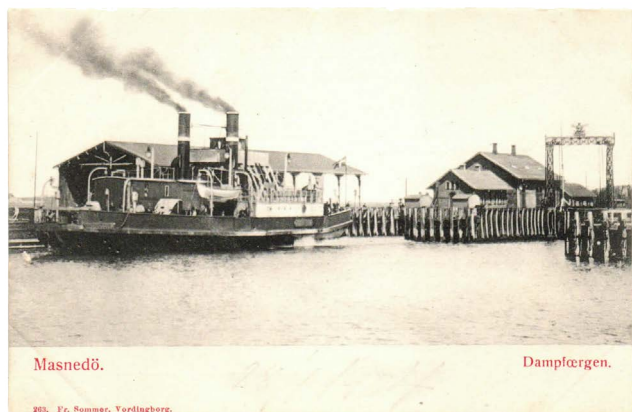
Ill. nr. 9 - I forbindelse med bygningen af den Sjællandske Sydbane til Vordingborg og anlægget af Falsterbanen etablerede man dampjernbanefarten over Storstrømmen i 1884. Dermed blev de Lolland-Falsterske private jernbanelinjer i forbindelse med det øvrige danske jernbanenet.
